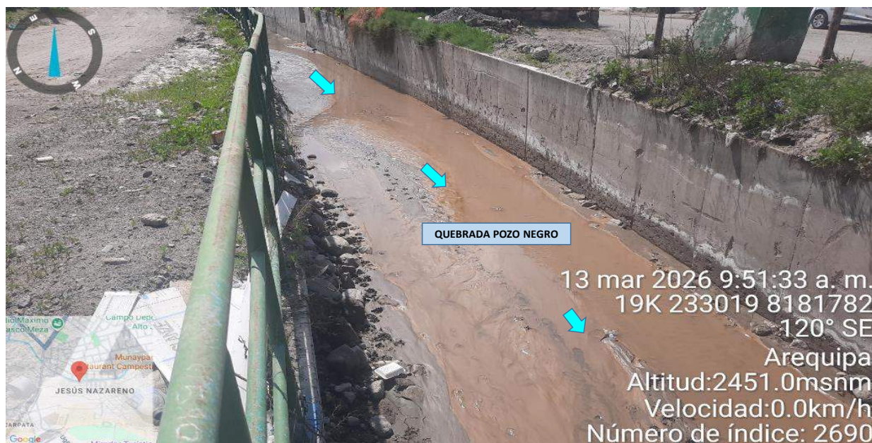
IMAGEN 02: EN ESTE TRAMO SE OBSERVA EN AMBAS MÁRGENES DE LA QUEBRADA POZO NEGRO, SE ENCUENTRA CON CONCRETO EN MAL ESTADO, A UNA ALTURA DE 2m, APROX. Y SU CAUCE SE ENCUENTRA COLMATADO DE SEDIMENTO.
