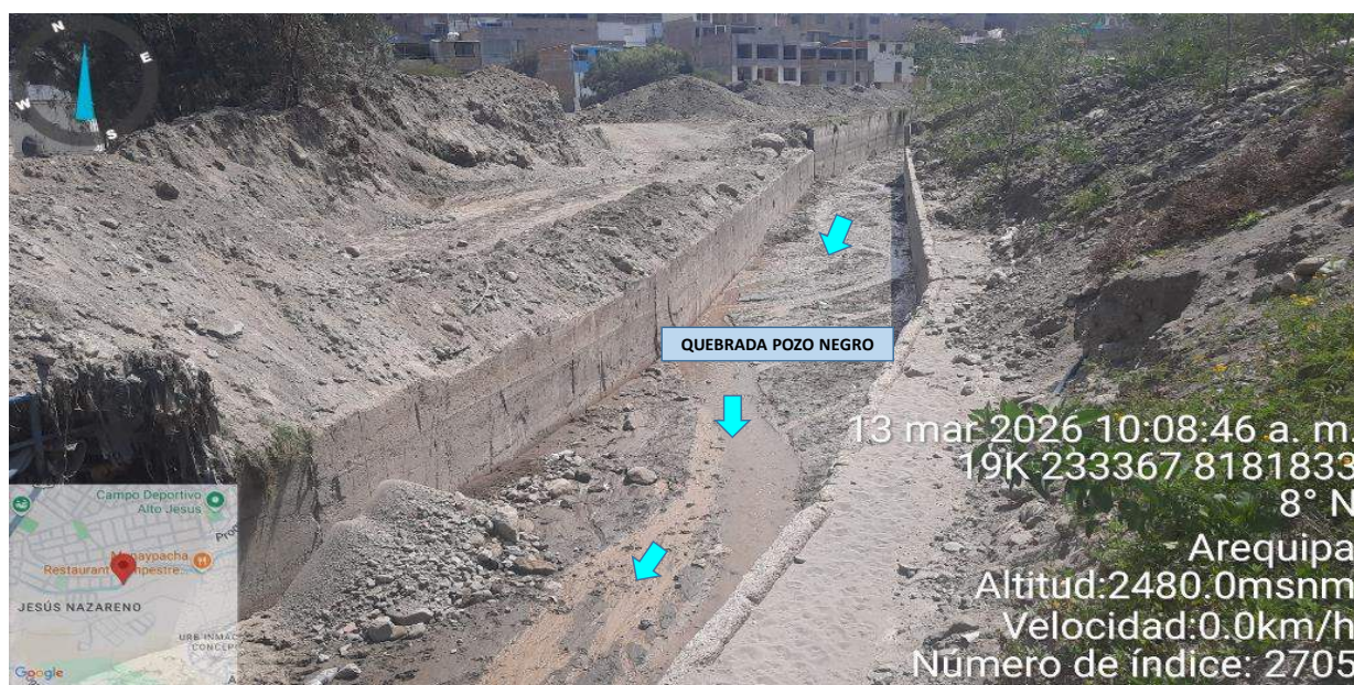
IMAGEN 03: EN ESTE TRAMO SE OBSERVA EN AMBAS MÁRGENES DE LA QUEBRADA POZO NEGRO, SE ENCUENTRA CON CONCRETO EN MAL ESTADO, A UNA ALTURA DE 2m, APROX. Y SU CAUCE SE ENCUENTRA COLMATADO DE SEDIMENTO.
